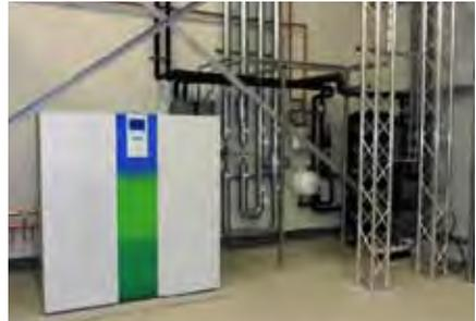
Bild 39: Power-to-Cool Anlage mit 15 kW<sub>Kälte</sub>
