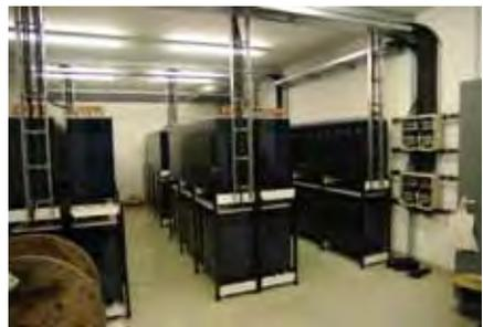
Bild 23: Batterieanlage mit 2 MWh installierter Kapazität
