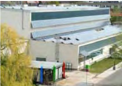
Bild 22: PV-Anlage mit 110 kVAP
