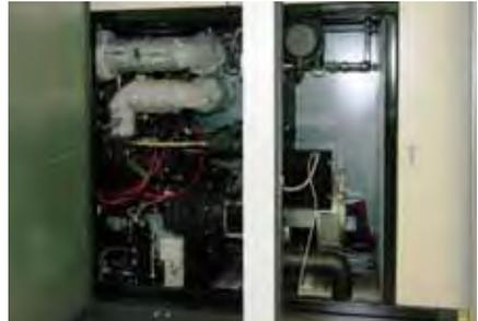
Bild 41: Blindleistungsfähiger Generator des BHKW
