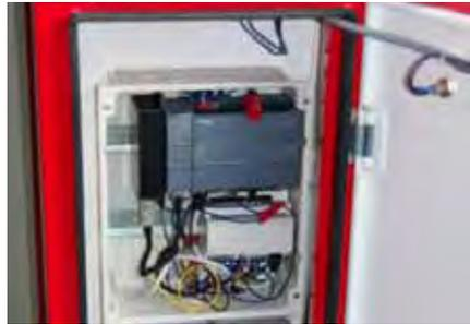
Bild 31: Kommunikationsmodul in der Ladesäule
